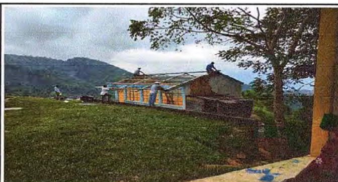
Foto 4: Cambio de estructura de madera por metal y lamina.
