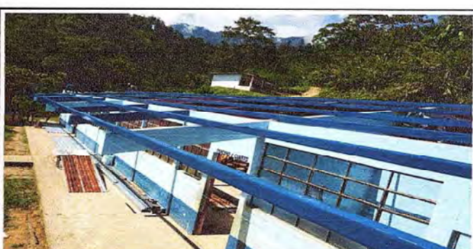
Foto 6: Pintado de estructura antes de colocar las láminas.
