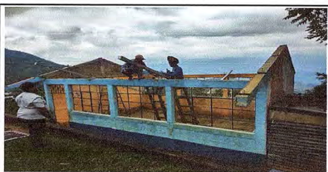
Foto 5: Cambio de estructura.
