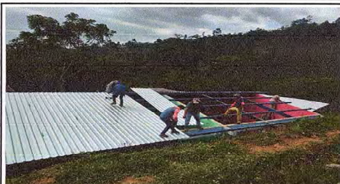
Foto 2: Colocacion de laminas de todo el establecimiento.
